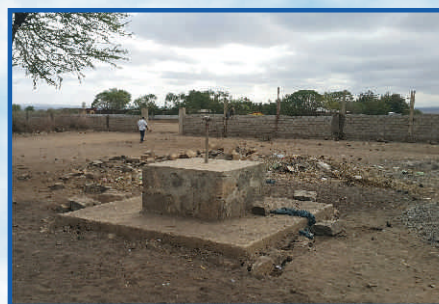
Die Schutzmauer nimmt Gestalt an. Im Vordergrund: Der Punkt, wo künftig das Wasser für die Schule ankommen soll.
