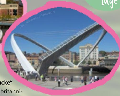
Die „**Millenium Brücke**“ in Newcastle in Großbritannien trägt den Spitznamen „blinzeldes Auge“. Die eigentlich ebenerdige Brücke kann bei Bedarf hochgeklappt werden, um Schiffe auf der Tyne durchzulassen. Dieses Hochklappen geschieht über die Längsachse und sieht dann aus, als würde das Augenlid aufgehen. Die Brücke blinzelt dir sozusagen zu.
